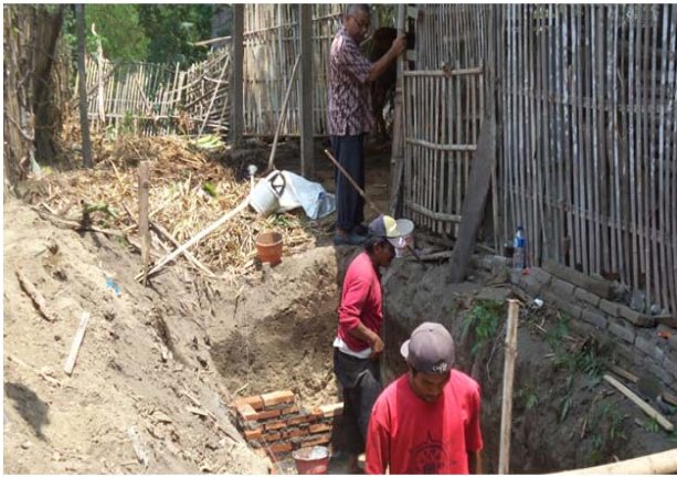
Gambar 1. Persiapan pemasangan tembok bata untuk bak digester
