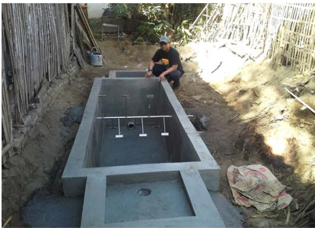
Gambar 2. Pembuatan Bak Digester
